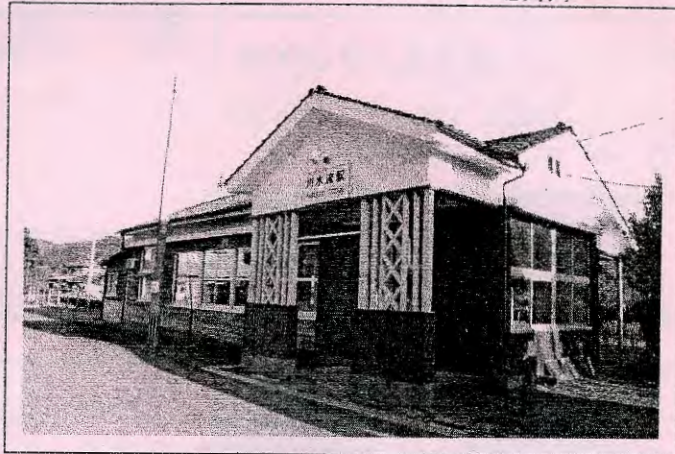
木造の駅舎は約70年間、人々に親しまれ町の玄関口として活躍してきました。
