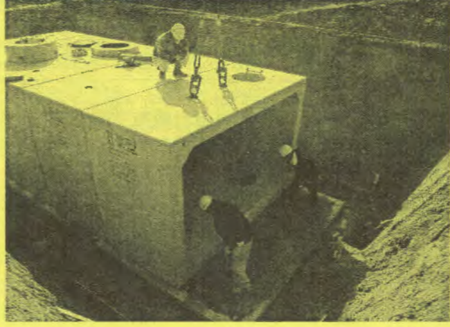
（地下埋設型耐震性防火水槽の本体据付状況）
