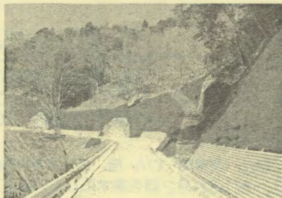
（整備の進む林道下鹿川・上鹿川線開設工事）
