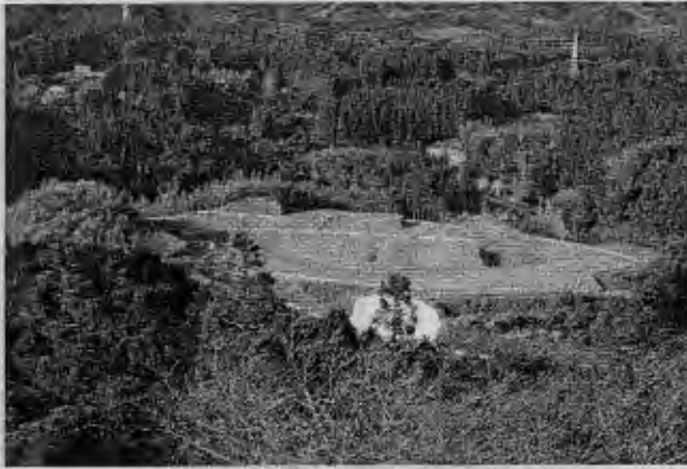
整備の進む北方インター公園(荒平公園より)
