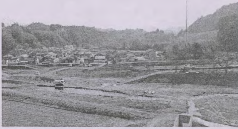
(工事の進む下曾木地区)
