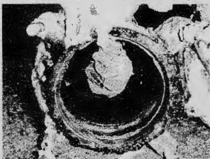
異物の噛み込みによるポンプ故障
